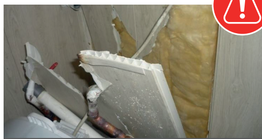
ARRACHEMENT DU MUR
