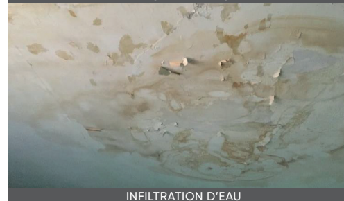
INFILTRATION D'EAU
